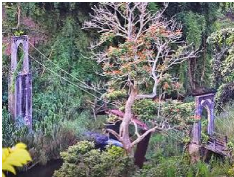
Figura 2: Puente de Hamaca, Bo. Honduras, Cidra
